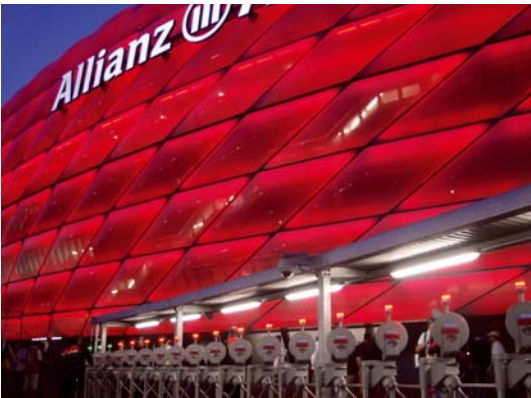
Le stade Allianz Arena à Munich équipé d'une solution SkiData.
